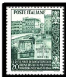
Ponte prima della distruzione
