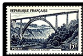
Viadotto Ferroviario Garabit - Cantal
