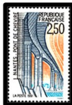
Il ponte di Cheviré à Nantes
